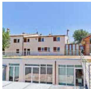
IMPIANTI TECNOLOGICI AD ELEVATA EFFICIENZA
