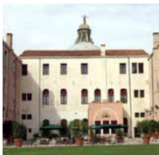
PROGETTAZIONE DI IMPIANTI AD ALTA EFFICIENZA
